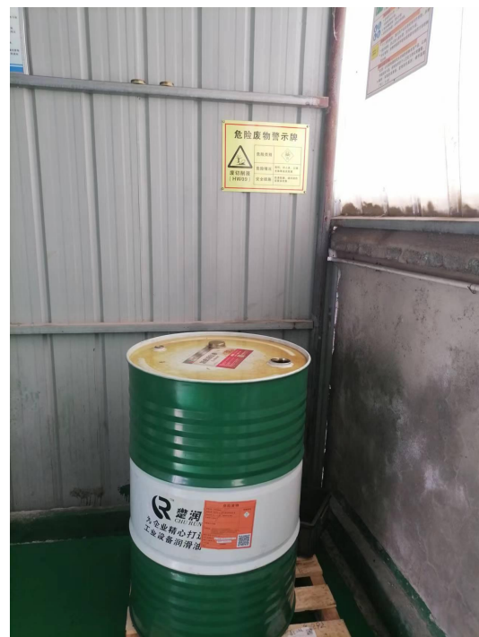
危险废物标签及警示牌
