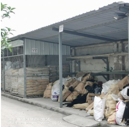
一般固废暂存间
